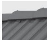
Максимальный зазор между нижней кромкой коньковой черепицы и верхушками волн рядовых черепиц должен составлять не более 15 мм. Установка креплений бруса производится после набивки обрешетки.
